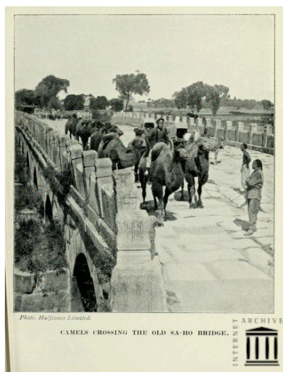
Chameaux traversant l'ancien pont de Sa-Ho
